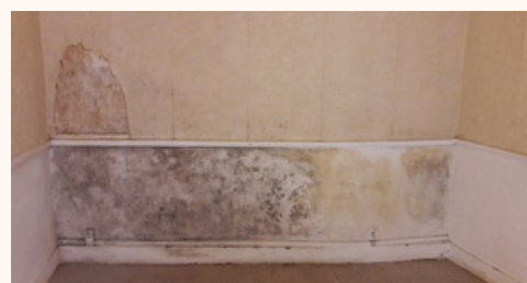
Photo de la salle de bain avant travaux
