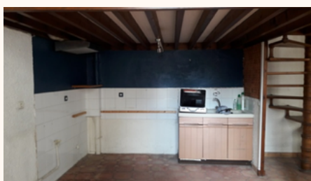
Photo de la cuisine avant travaux
